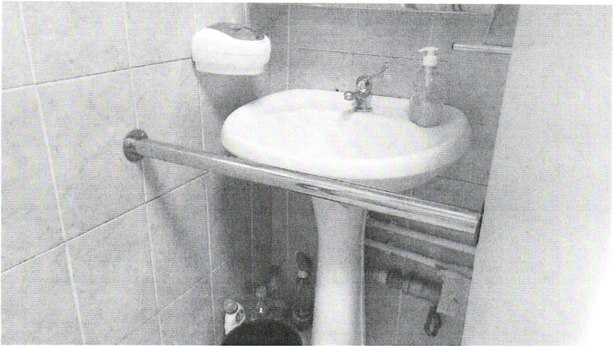
Рисунок 52. Раковина в санузле, оборудованная поручнем
