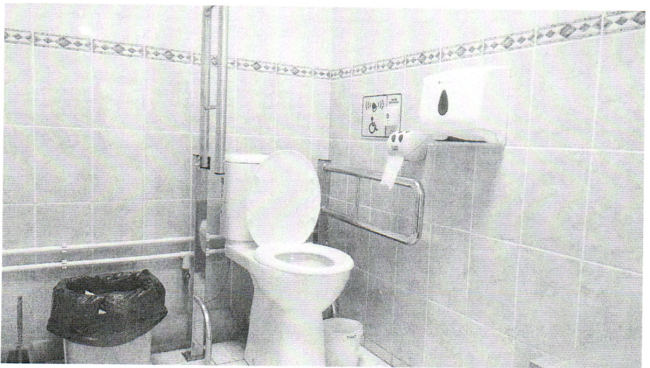
Рисунок 51. Комната санузла с унитазом для инвалидов, оборудованным универсальной системой вызова
