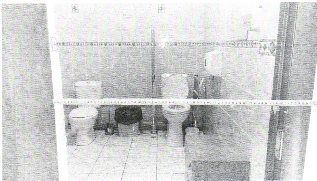
Рисунок 49. Вход в санузел первого этажа (ширина 67 см)
