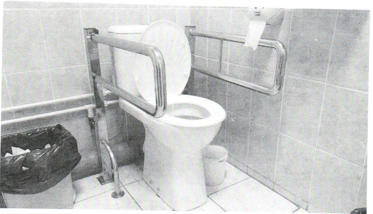
Рисунок 50. Комната санузла с унитазом для инвалидов, оборудованным поручнями
