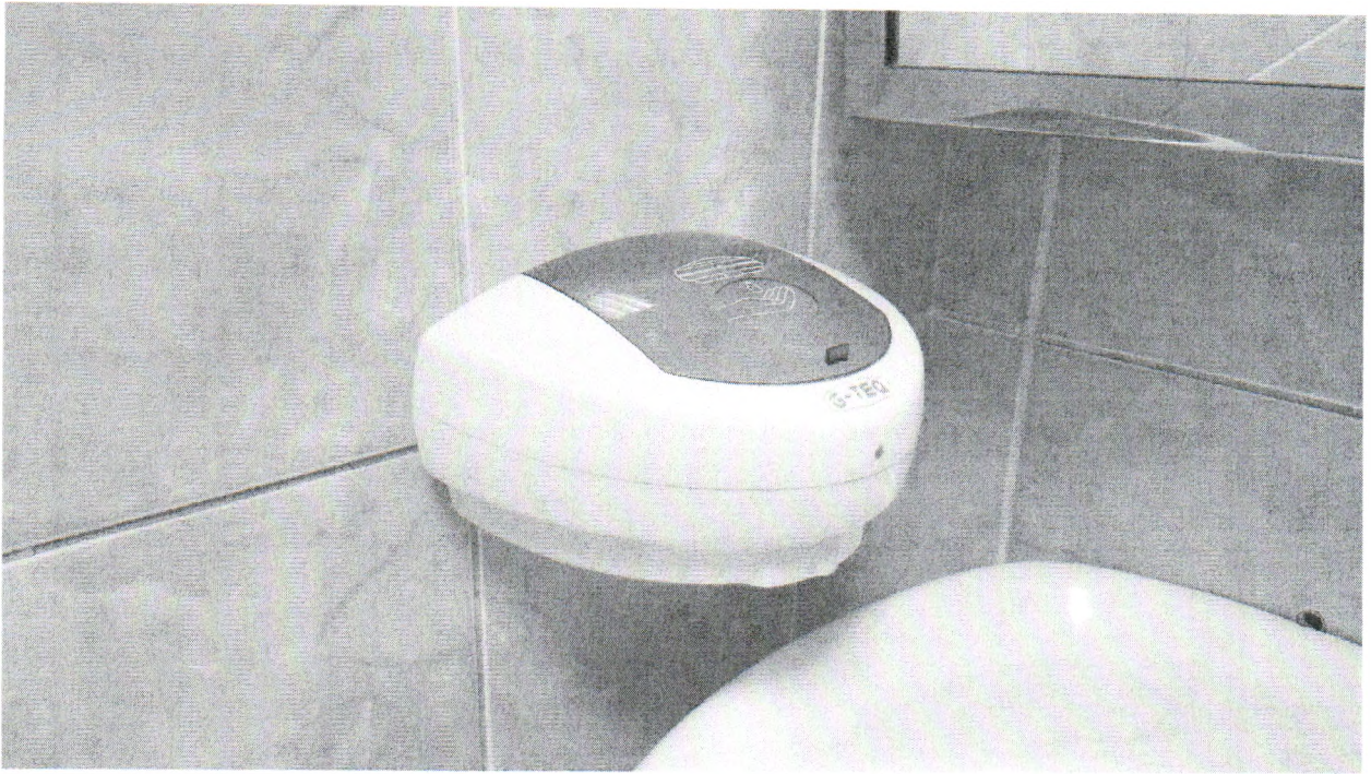
Рисунок 54. Оборудование в санузле (сенсорный дозатор мыла для людей с ограниченными возможностями)
